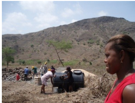
Figura 6 - População local em trabalho coletivo de construção de reservatório para captação e armazenamento.
