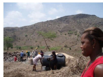
Construção coletiva de reservatório para captação de água, Cabo Verde Páginas 5 a 7
